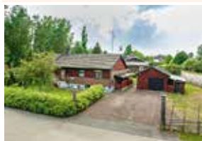
Kråkberg | Mora Oståkersvägen 10
